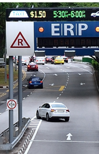
Em Singapura, a zona de cobrança de congestionamento é delimitada por letreiros suspensos que indicam o preço atualizado para entrar na zona. FONTE: Tim Adams, Flickr
