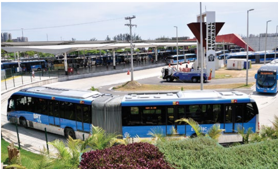
Figura 66 – Terminal Alvorada do BRT do Rio de Janeiro/RJ.
