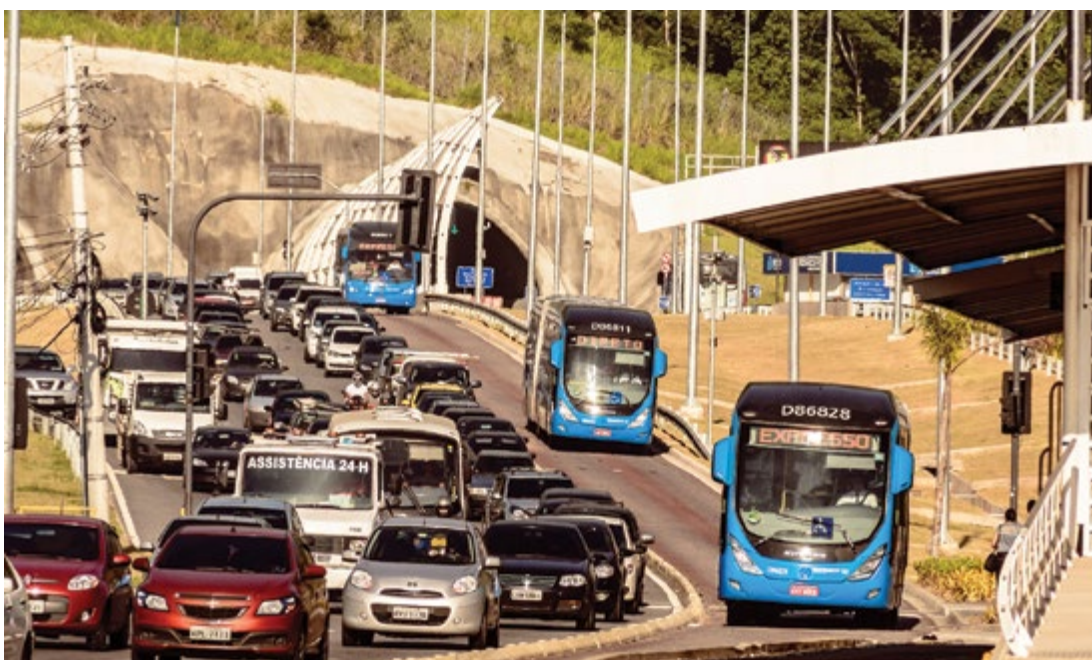
Figura 13 – BRT TransOeste, no Rio de Janeiro/RJ.
